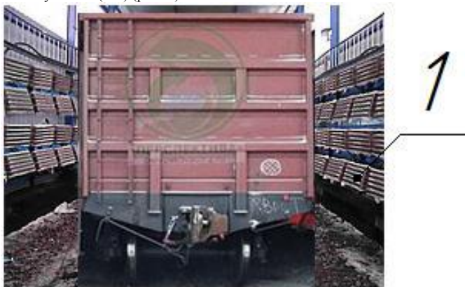
Рисунок 1- Размещение вагона с углем в цеху углеподготовки: 1 – элементы с инфракрасным излучением для размораживания угля
