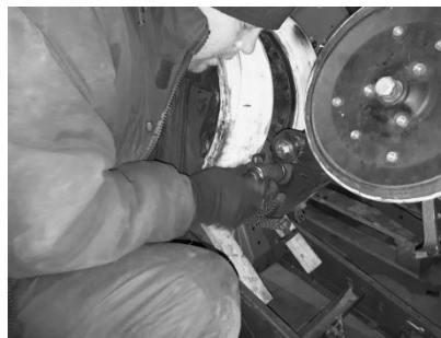
Рисунок 8.7 – Технологія збирання лап посівного комплексу «JohnDeere 1780»: а – запресування втулки з ПКМ; б – монтаж важелів на посівну лапу; в – посівна лапа у зборі
