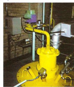
Установа основного паливника, пристрою запалювання, та датчика контролю полум'я на кришці АЗС
